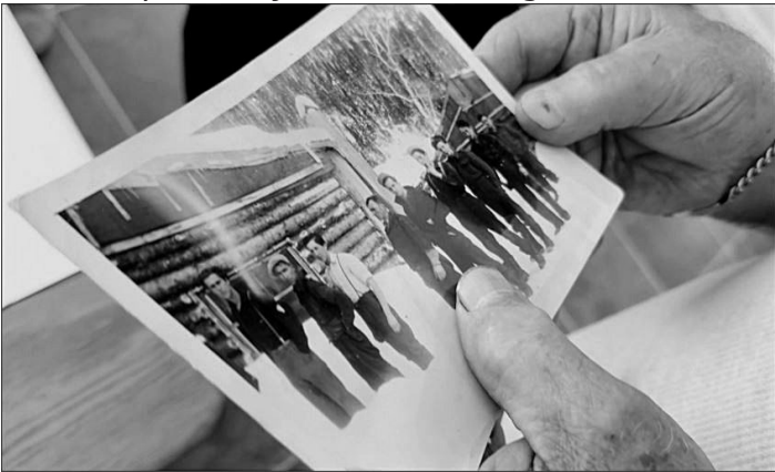
Mon grand-père et ses collègues au chantier - archive de mon oncle Roland Sirois
