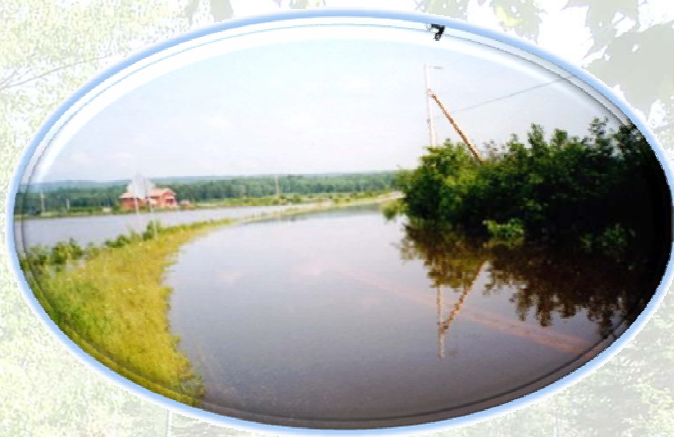
Inondation 2002, rivière du Loup au pont du 5 e rang
